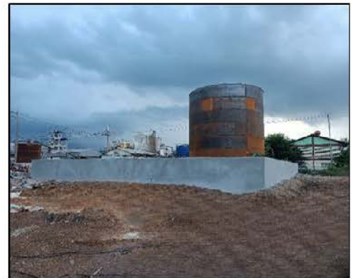
ถังเก็บพักกรดไฮโดรคลอริก และเชื่อมกันป้องกันการรั่วไหล ของสารเคมี
