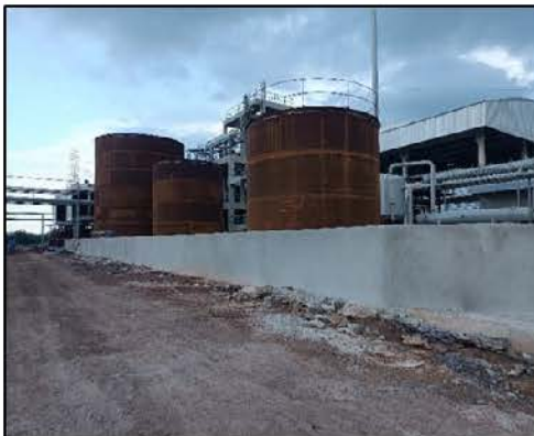
ถังเก็บพักโซเดียมไฮดรอกไซด์ และเชื่อมกันป้องกันการรั่วไหล ของสารเคมี
